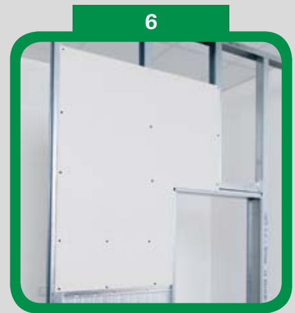
6 Usazené a zabudované pouzdro
