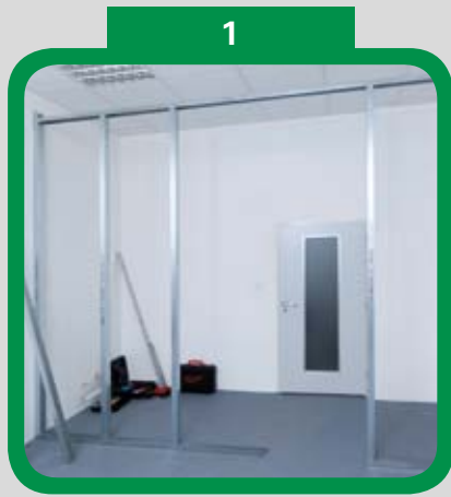
1 Příprava profilů SDK pro usazení pouzdra
