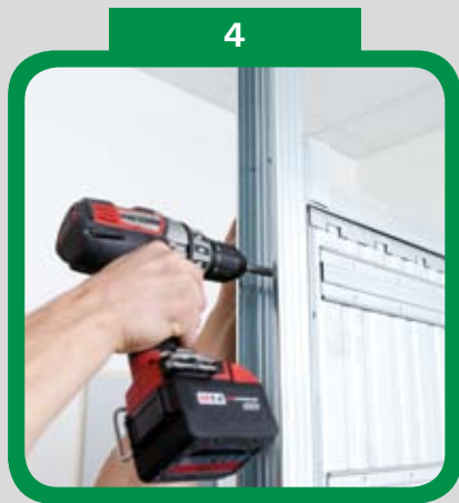
4 Přípevnění pouzdra ke konstrukci SDK
