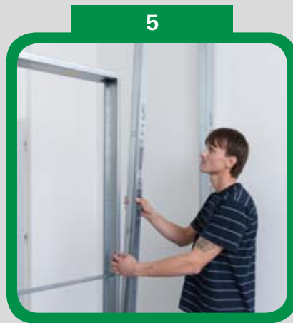
5 Montáž protilehlé strany SDK konstrukce
