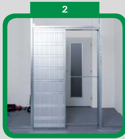
2 Usazení pouzdra do spodního profilu SDK
